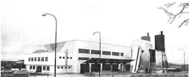
Bild 9. Betonwerk Fa. Germa Trading Ltd., Brno Fig. 9. Concrete factory Messrs. Germa Trading Ltd., Brno Fig. 9. Usine pour la fabrication des blocs Ets Germa Trading Ltd., Brno
